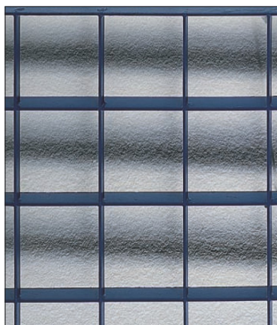
Particolare del rivestimento in lamiera zincata microforata (fori \varnothing 6mm)
